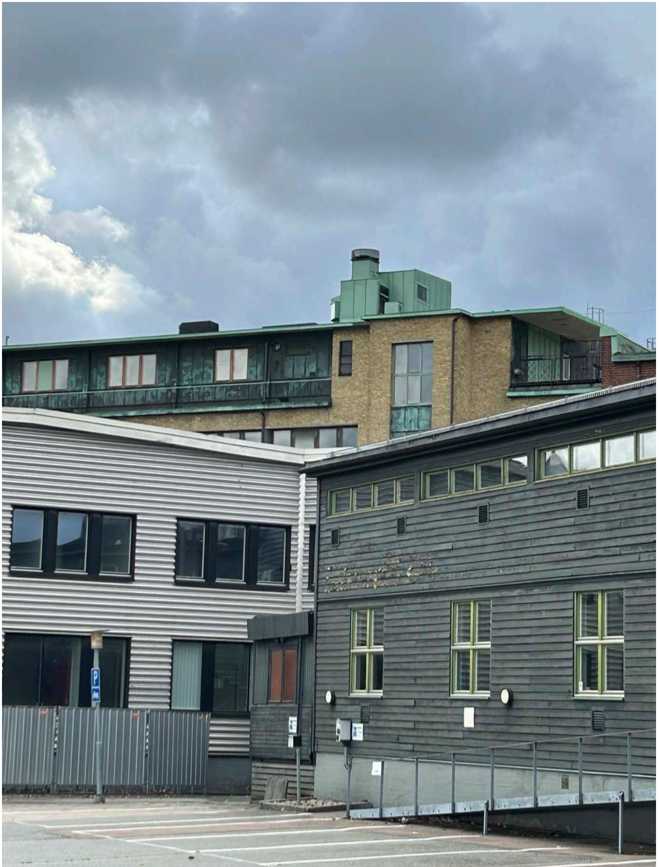
Vy över fastigheten från gården. En brokig upplevelse med huskroppar, fasadmaterial och uttryck. På Turitzhusets tak skymtar delar av den ursprungliga vinterträdgården och takterrassen. Foto: Ulrika Lindh
