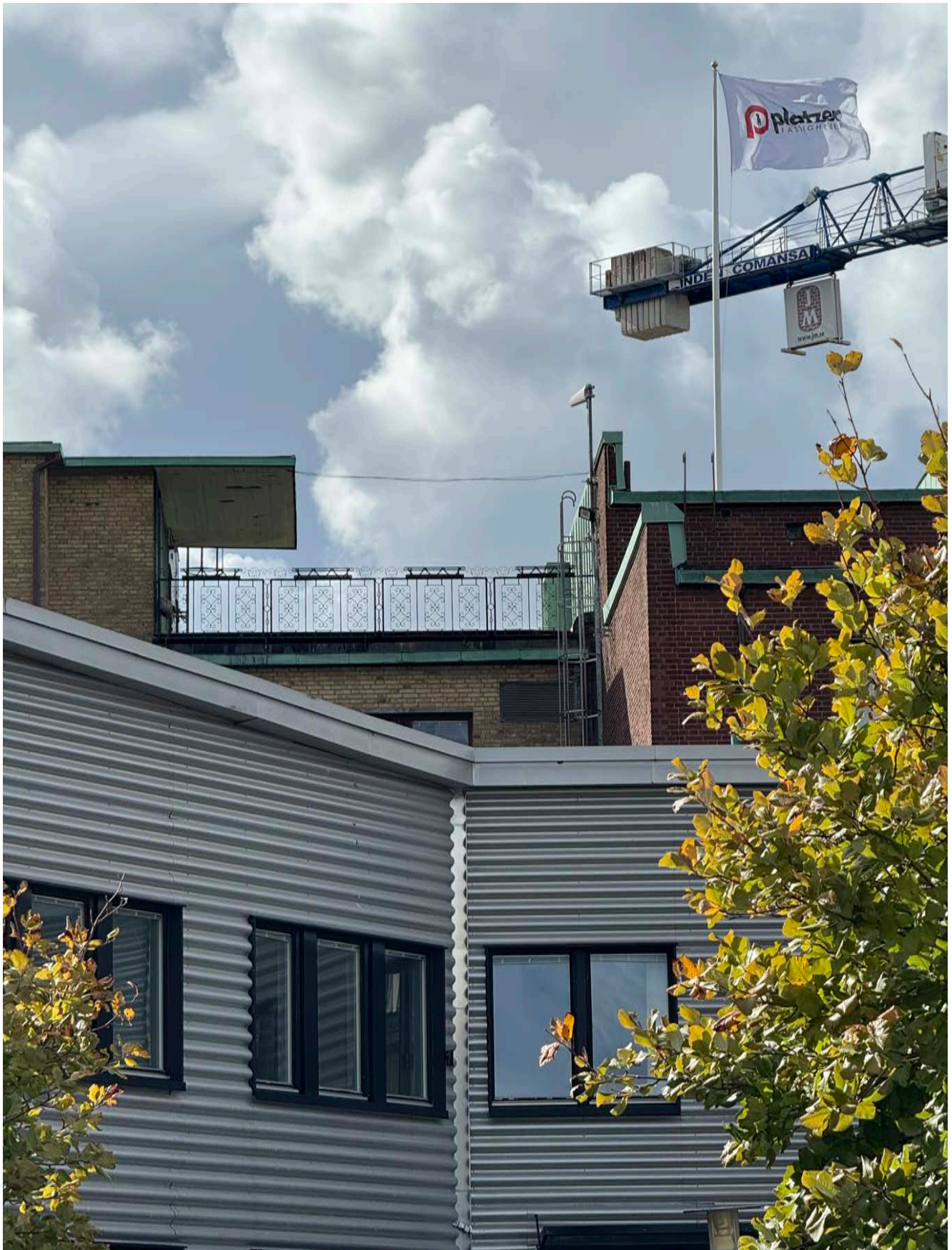
Exteriör lagerbyggnaderna som byggts om till kontor, i bakgrunden syns takterrassen och den förbyggda fasaden på det ursprungliga gula tegelhuset.
