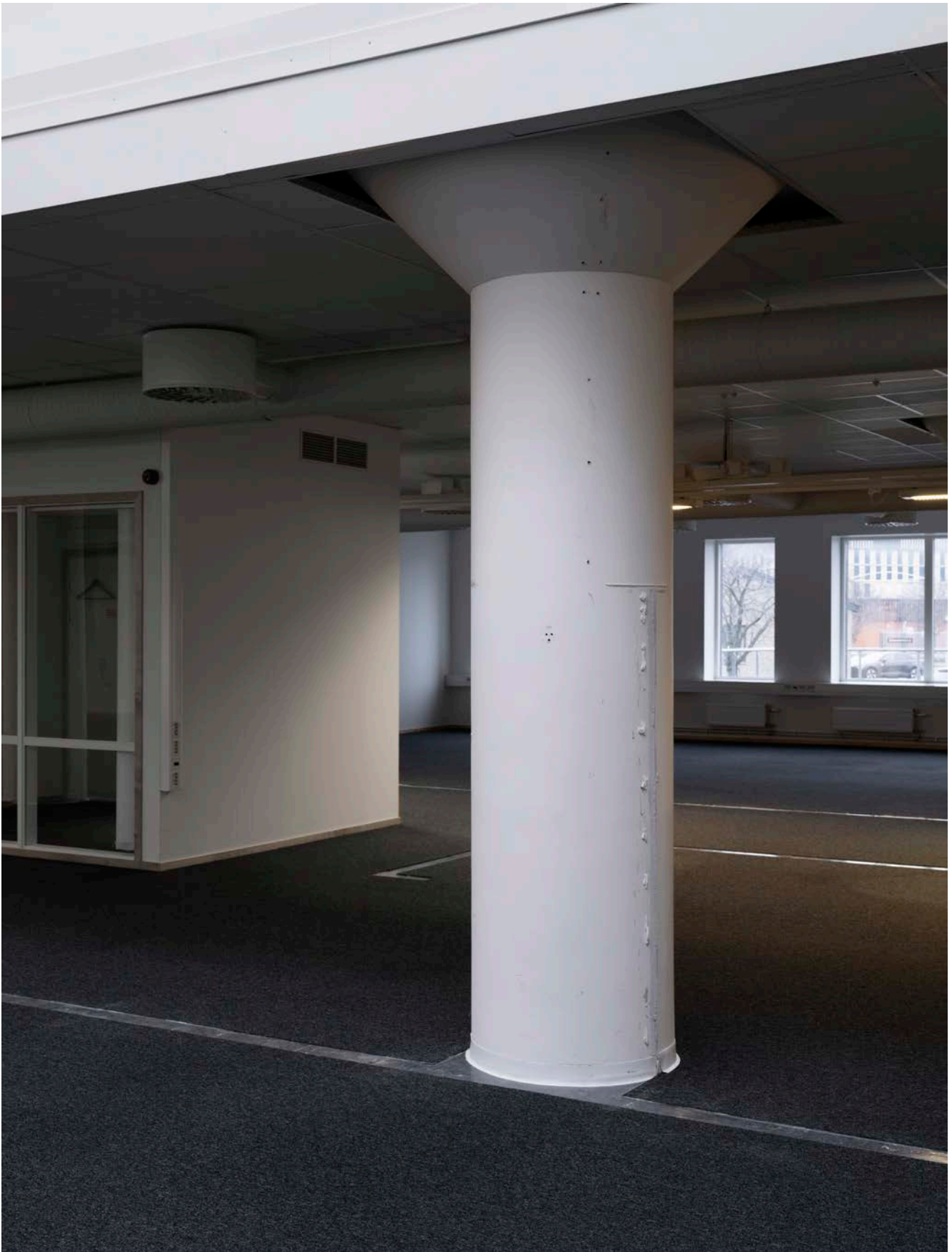
Interiör lagerdelen som byggts om till kontor. Foto: Kalle Sanner
