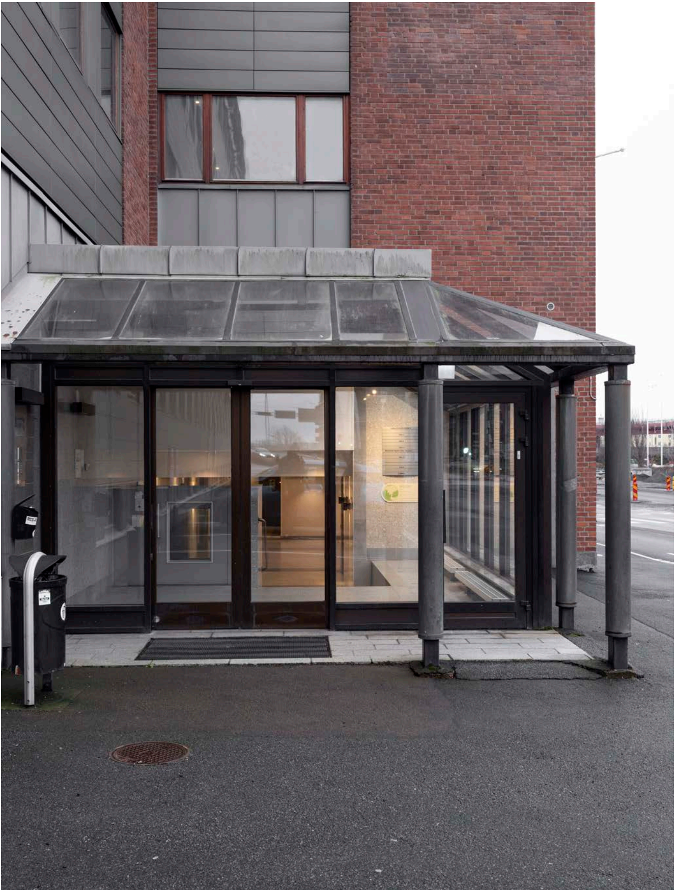
Huvudentrén idag. Ett inglasad vindfång leder till en hisshall som ligger en knapp meter under gatuplan. Foto: Kalle Sanner
