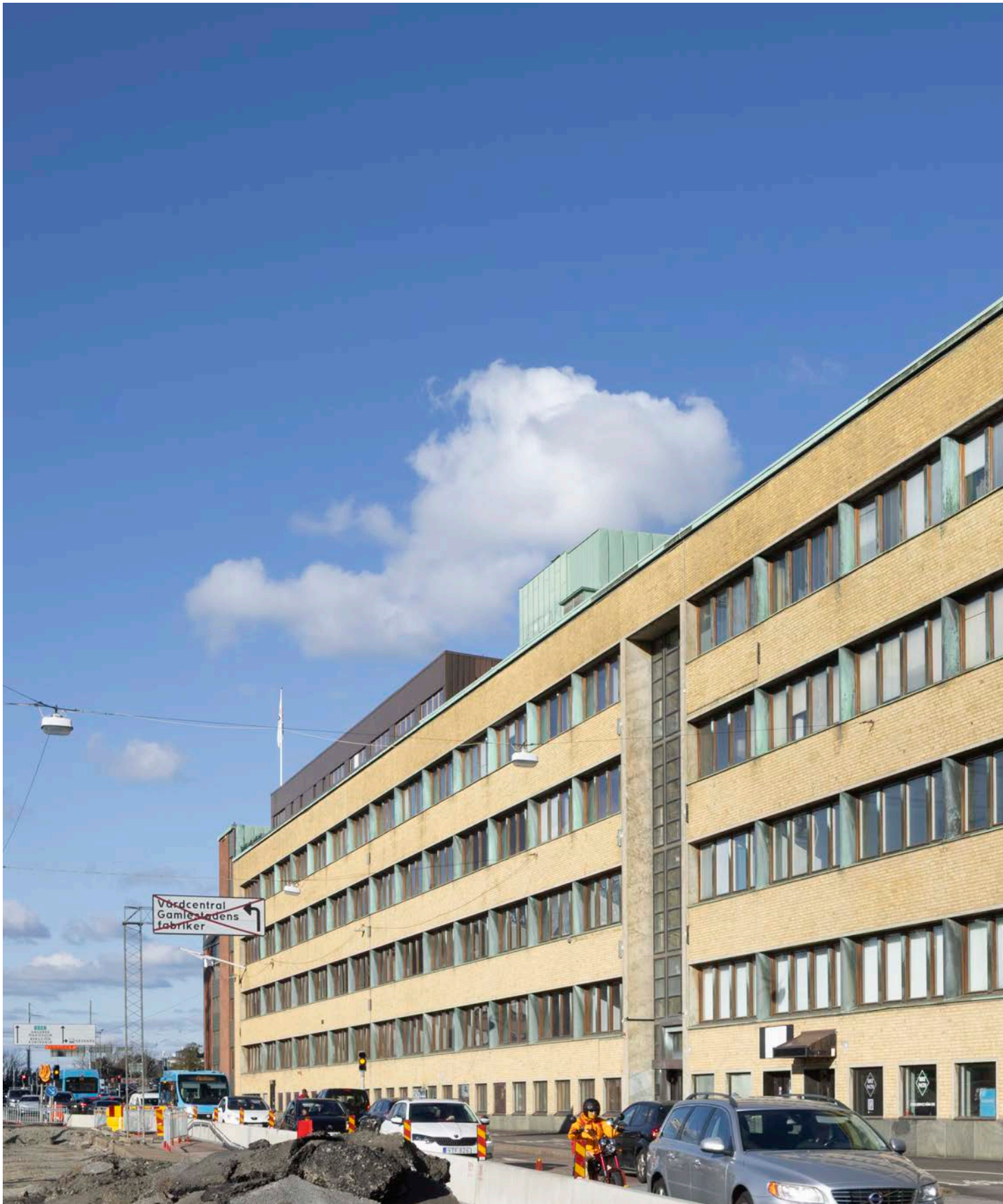
Turitzhuset sett söderifrån, oktober 2025. Motsvarande bild sida 20-21. Foto: Kalle Sanner
