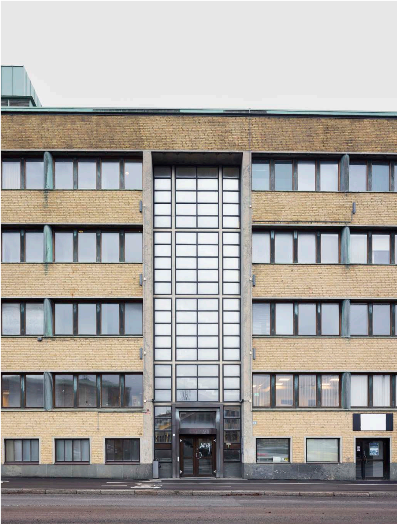
Dagens entré med utbytt entrédörr, borttaget skärmtak med skylt. Foto: Kalle Sanner
