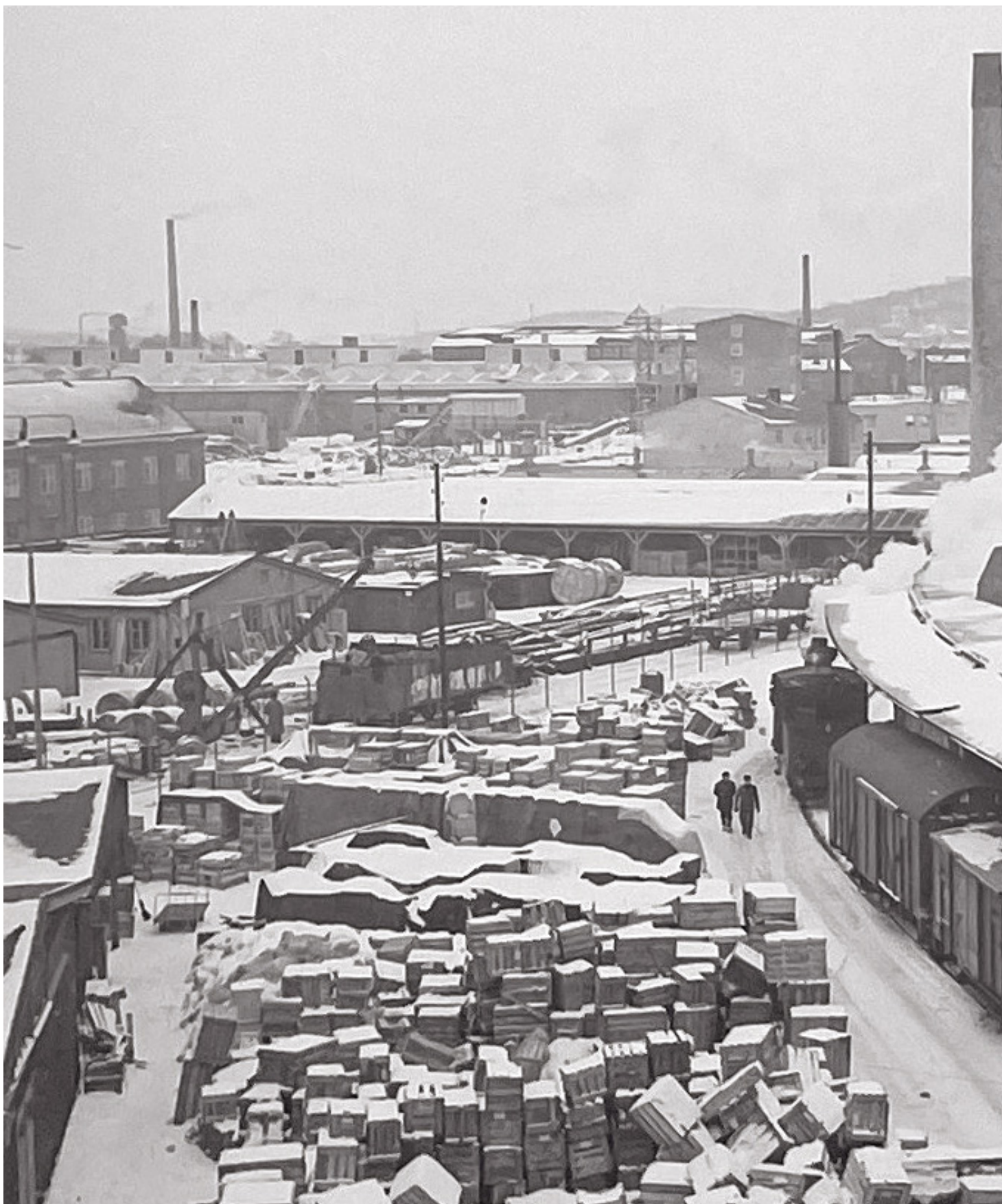
Vy inifrån kontorsbyggnaden mot innergården, 1940-tal. Lagerbyggnaden syns här i sin ursprungliga form med perronger för godståg, glaslanterniner i tak och skärmtak i glas över perrongerna. Innergården är fylld av varor som sannolikt kommit in via Göteborgs hamnar för vidare transport ut till butiker. Motvarande bild idag på sida 94-95.
