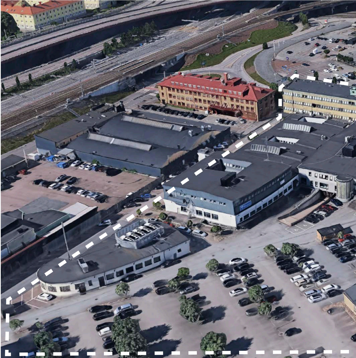
Flygfoto över arbetsområdet för fallstudien. Fastighet: Bagaregården 17:26 Adress: Gamlestadvägen 3 Storlek: ca 20 000 kvm Byggnadsår: 1931/ 1941 / 1961
