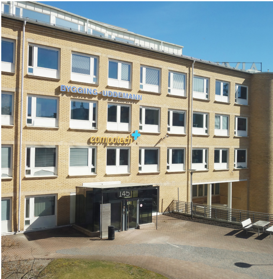
Foto 14: Hus K, fasad mot söder. Den rytmiska fönstersättningen speglar en flexibel planlösning.
