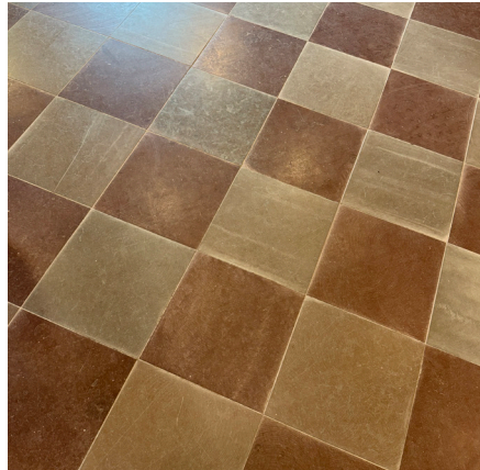
Foto 39: Entrégolv av kalksten lagd i rutmönster.
