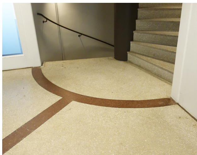
Foto 23: Gjutna terrazzogolv i trapphallar.
