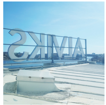
Foto 19: Skylten på Hus K:s tak är en talande detalj i berättelsen om kontorsparken Alviks strand.
