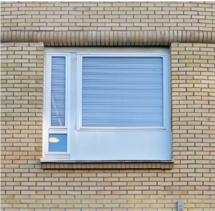
Foto 38: Fönster med halvrund tegelbalk och solbänk av tegel.
