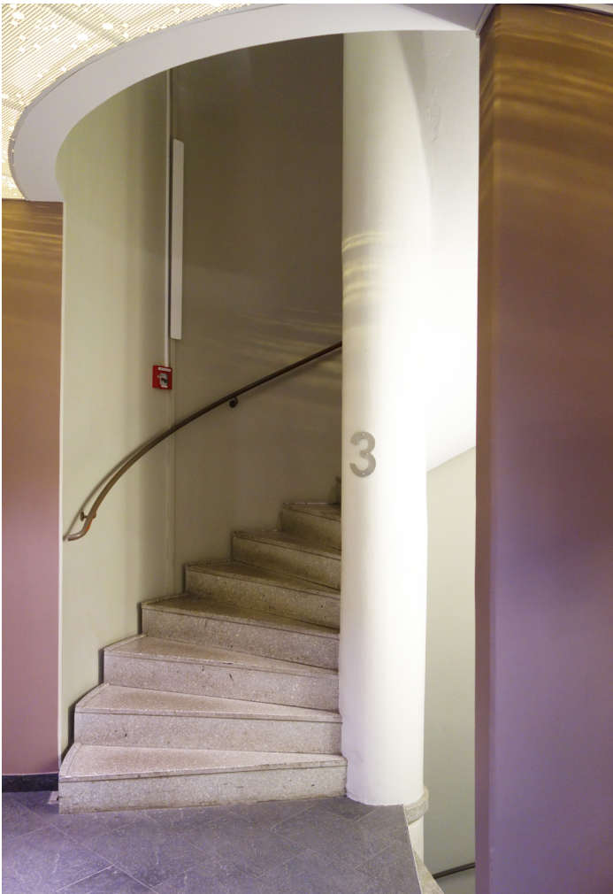
Foto 24: Plan- och sättsteg belagda med terrazzo.
