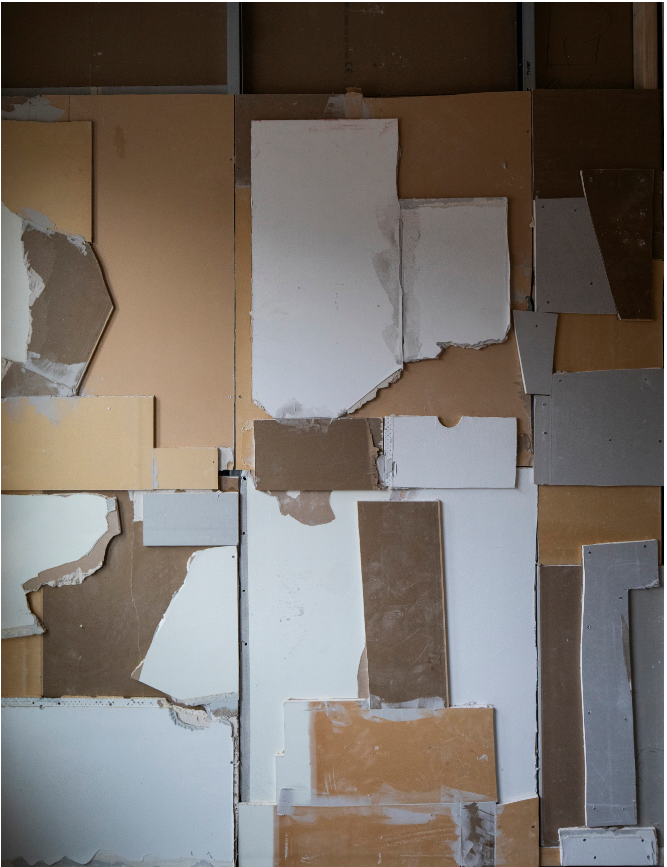
Foto 102: En ny vägg skapad av återbrukade element (Tove Falk Olsson)
