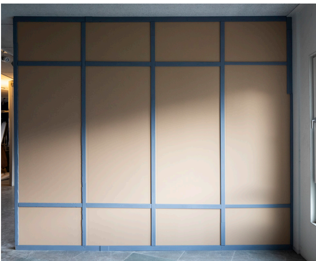
Foto 96: En av de "nya" väggarna (Tove Falk Olsson)
