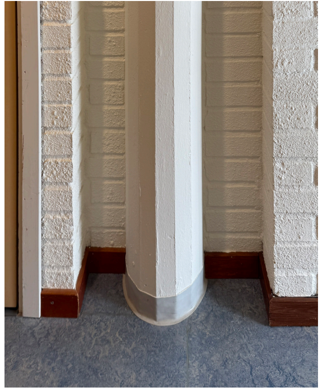
Fasetterad betongpelare.
