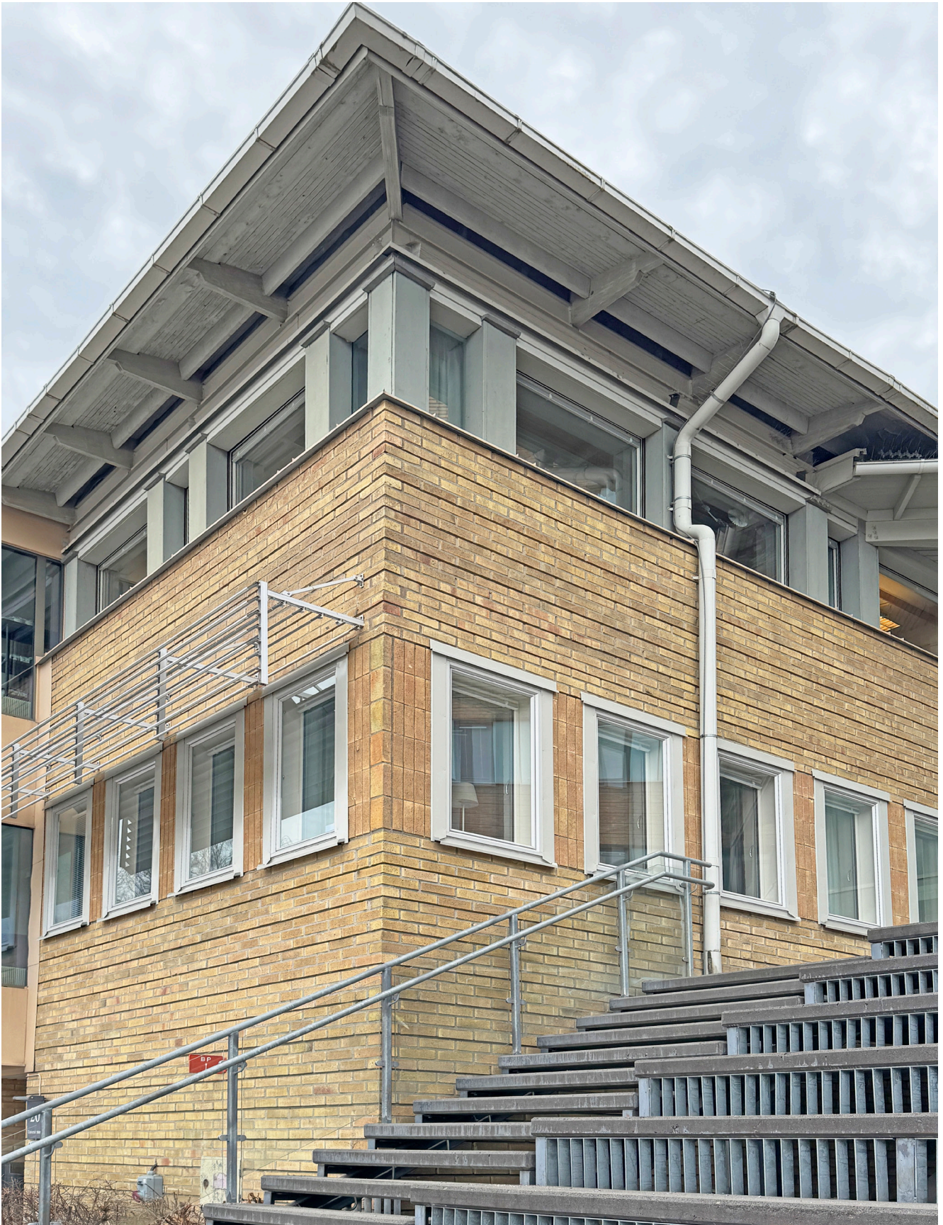
Förvaltningshusets hörn med den tillbyggda gradängen vid entrén mot parken..
