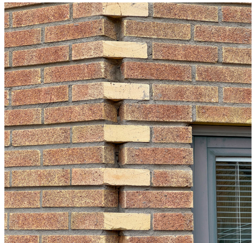
Befintlig fasaddetalj i Tornets sockel- Sandade gula tegelstenar med kapade hörn.
