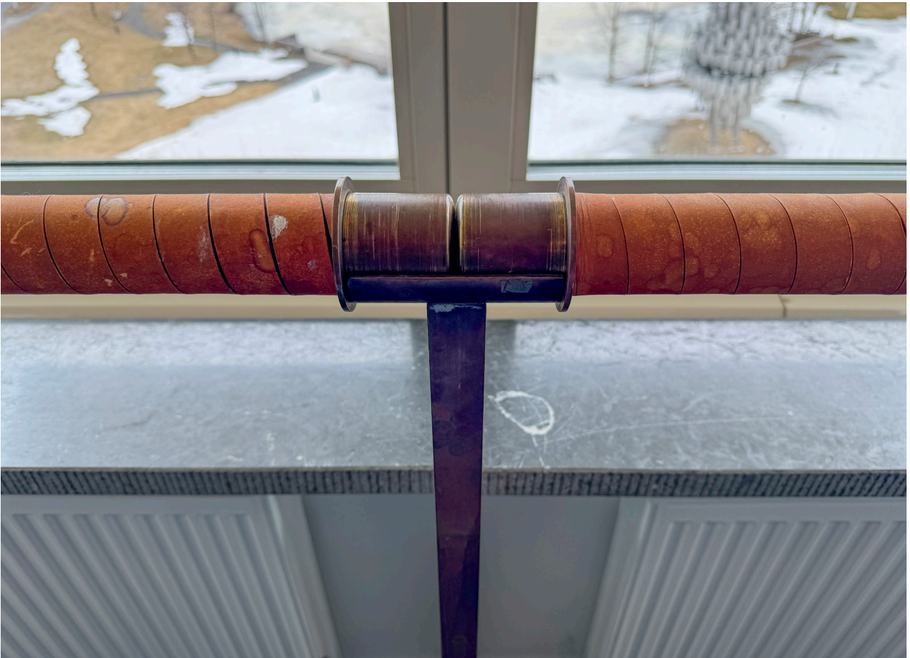
Innanför partiet från sammanträdesrummet möts handen av en vacker detaljerad handledare lindad i läder.
