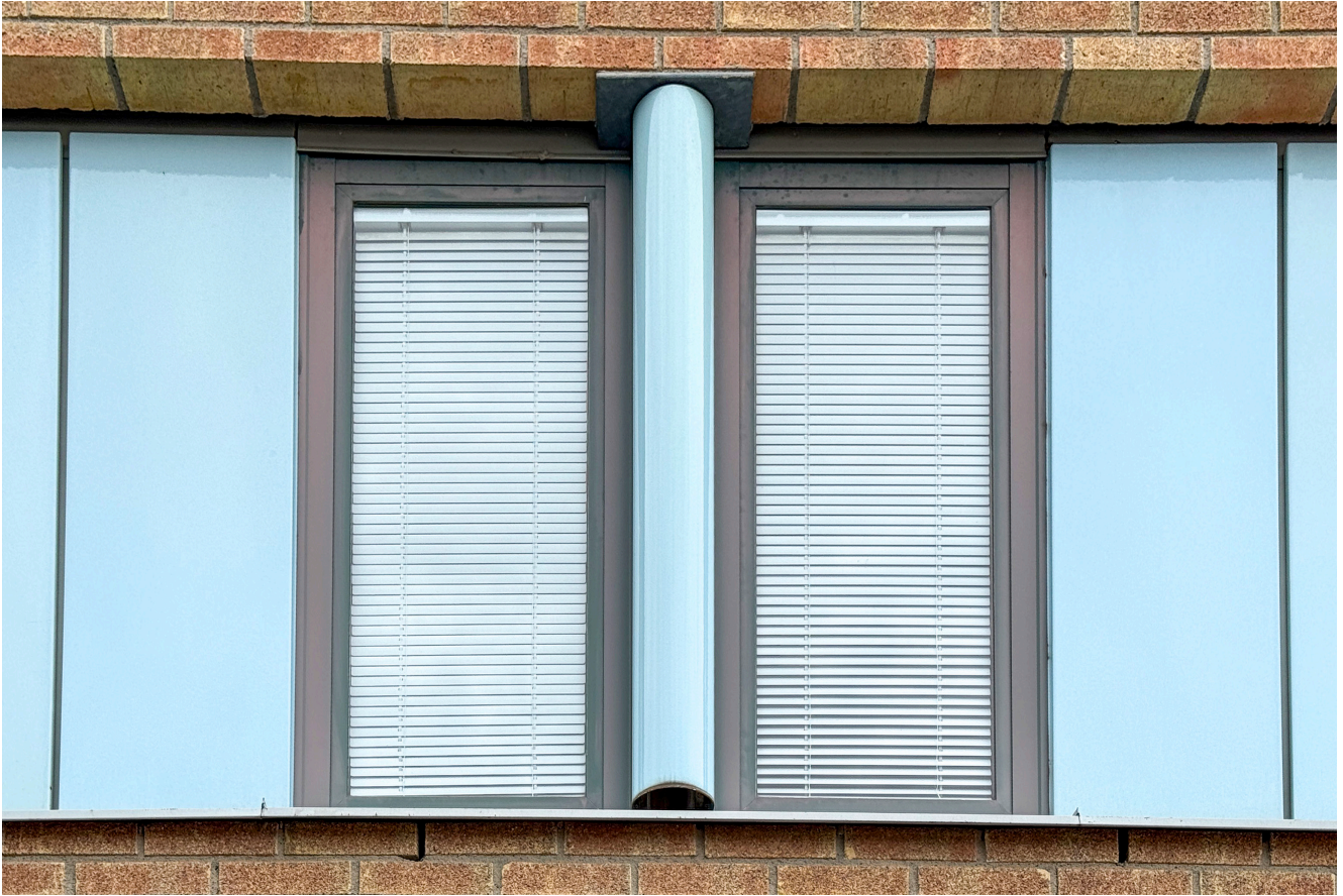
Tornet. Utvändiga plåtbeklädnader och detaljer av emaljerad stålplåt kompletterar fönsterbanden med plana kassetter och böjda inklädnader. Fönsterpartier är treglasfönster med kopplade bågar, insidan av bågen är i massivt trä, utsida i bränd aluminium med en kulör som liknar patinerad koppar.
