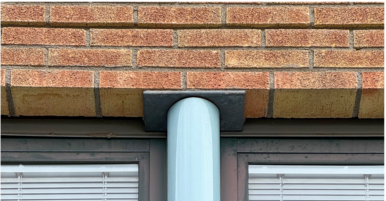
Tornet. Fönsterbandsdetalj. Överliggaren är utformad som skuren ur tegelmuren. Mellan fönstren finns dekorativa detaljer som påminner om mindre pelare med kapital framtagna av emaljerad stålplåt i en ljusblå kulör.
