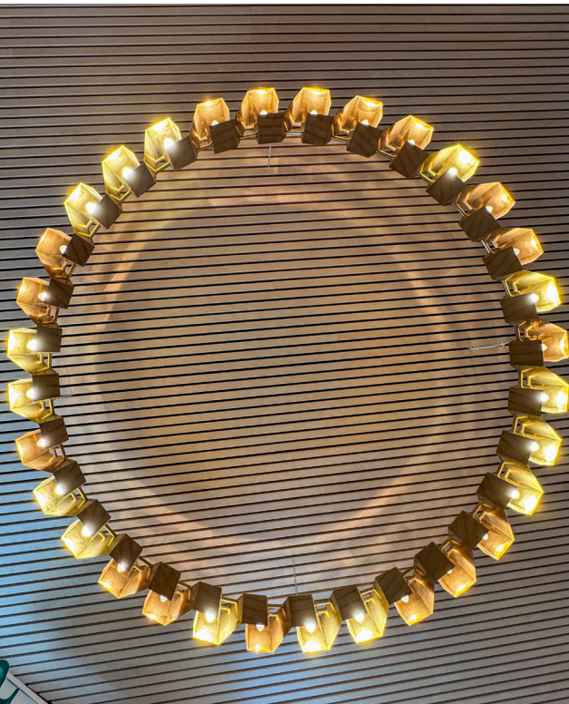
Takkronan är specialritad för huset i bockad mässingsplåt. Idag är lampan placerad i förrummet till sammanträdersrummet.
