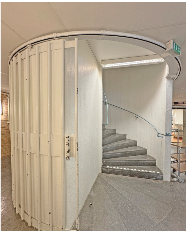
Platsgjuten originals spiraltrappa i förvaltningshuset på plan 01.
