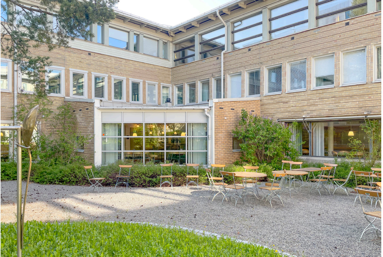
Mindre tillbyggnad från 2003 mot gården.
