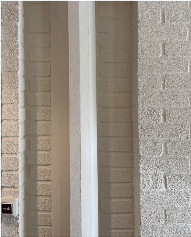
Fasetterad betongpelare.
