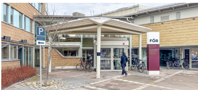
Entrétillbyggnad från 1999, utökad länk och tillkommande skärmtak mot stadens sida.
