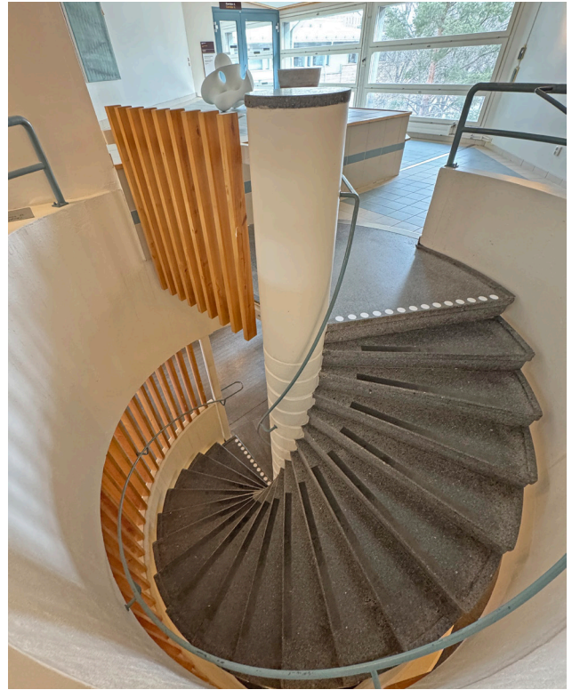
Förlängd spiraltrappa mellan plan 03 och 04 i samband med påbyggnad.
