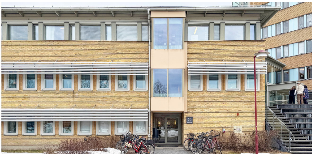
67's byggnad med 90-tals påbyggnad och burspråk samt solskyddslameller. Till höger, 90-tals tillbyggt panoramahiss samt gradängtrappa från 2007.
