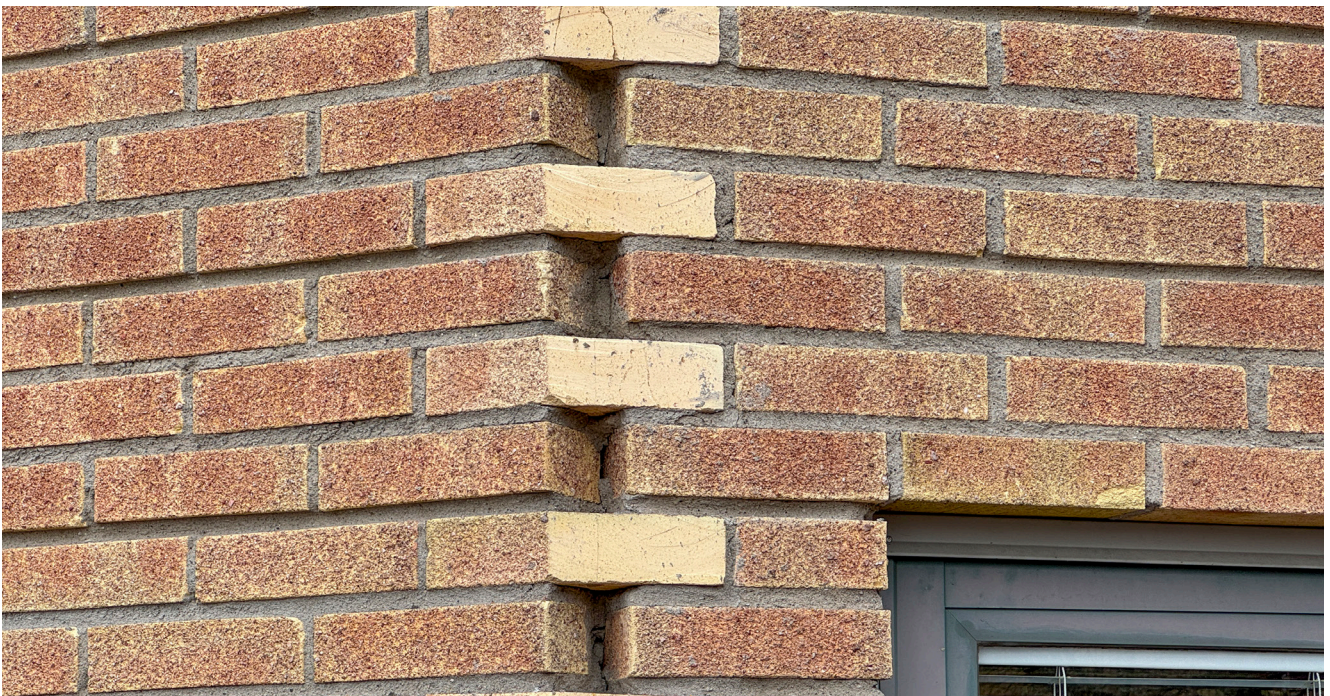
Tornet. Särskild tegeldetalj i gavelhörn i sockelhöjd på plan 02 mot park där man "syr" ihop murverket med sågade stenar vartannat skikt.
