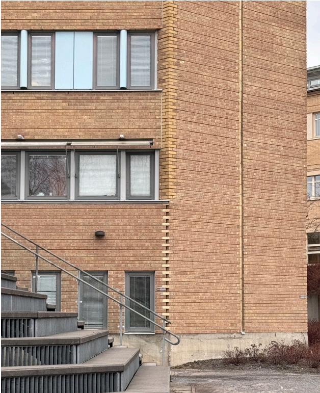
Tornets sockel är utformad med tjockare ytterväggar och avvikande fönstersättning. Gradånguppbyggnad är ett senare tillägg. Se hur utformning av gavelns hörn förändras i vertikalen.
