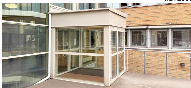
Entrétillbyggnad från 1999, utökad länk och tillkommande vindfång mot parkens sida.
