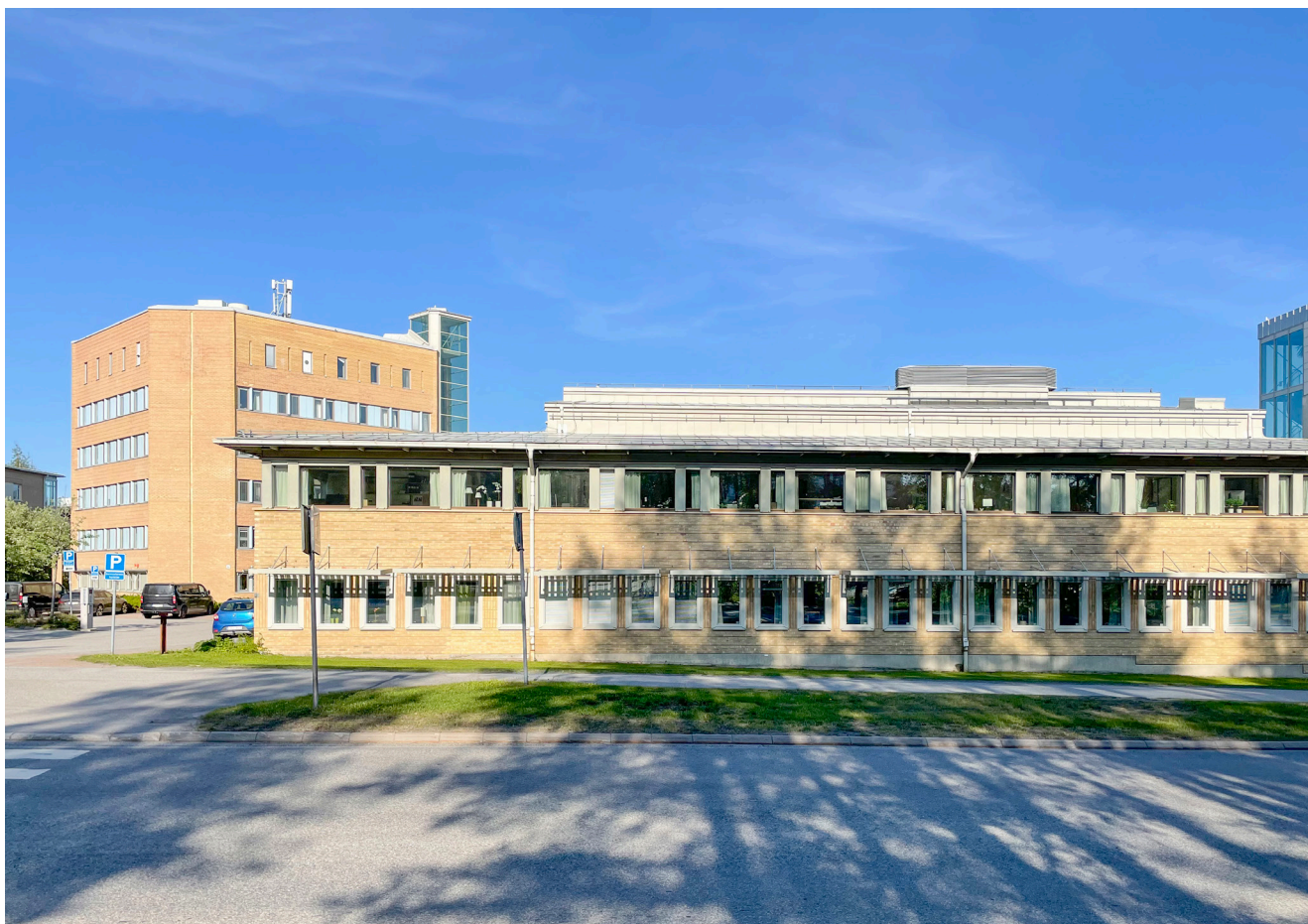
Vy från Universitetsvägen. Administrationsbyggnaden från 67 i förgrunden, påbyggnad med en våning och ett utstickande fläkrum på taket. "Tornet" från 83 i bakgrunden och dess tillbyggda hiss från 99.
