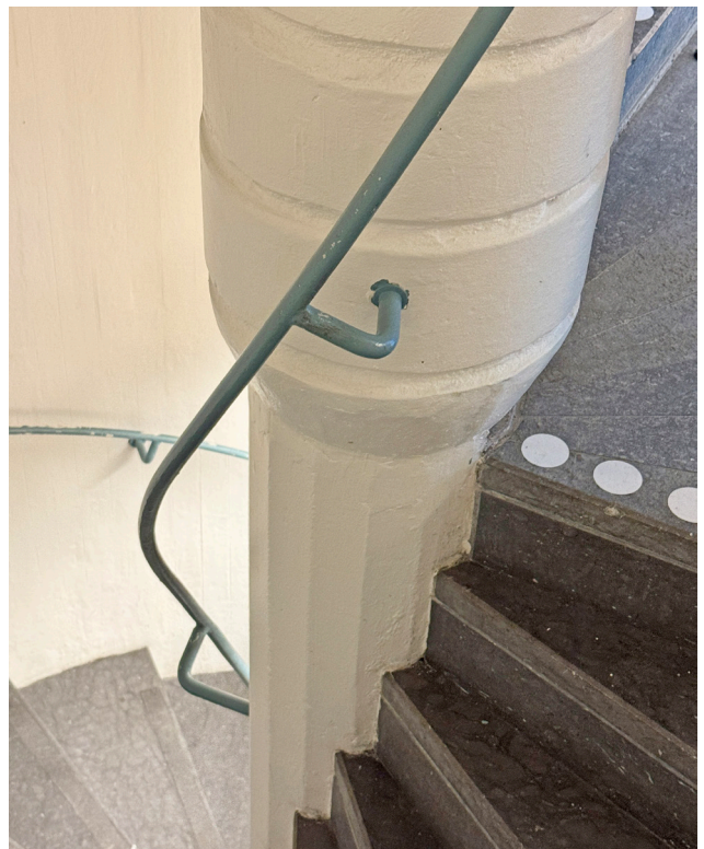
Övergångsdetalj mellan ursprungstrappa i platsgjuten betong, och förlängd trappa med prefabricerad lösning.
