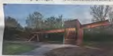
Chop Shop är ett projekt som Anders ritat i Indianapolis museum of Arts. Projektet är helt byggt av ett enda lokalt skräddat trä. Träets bark är husets fasad, gungor, klöstar och konstruktionsvirke är taget från trädet. Träets sirap såldes iifrån kiosk. FOTO: FRANK LÖNNER
