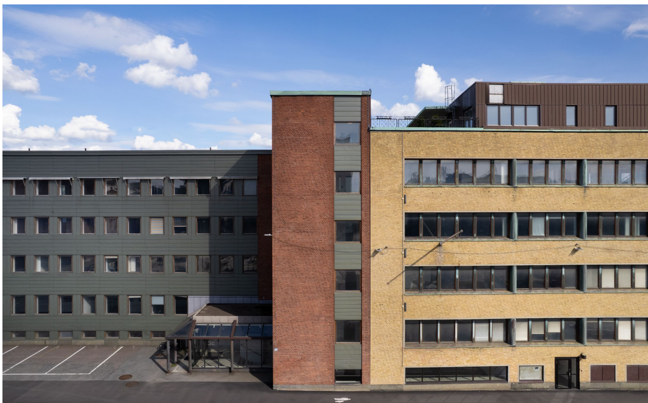
Ovan och nedan: Turitzhusets fasad längs Gamlestadsvägen. Foto: Kalle Sanner
