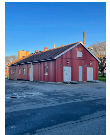
14. Maskinhus och gasrum
