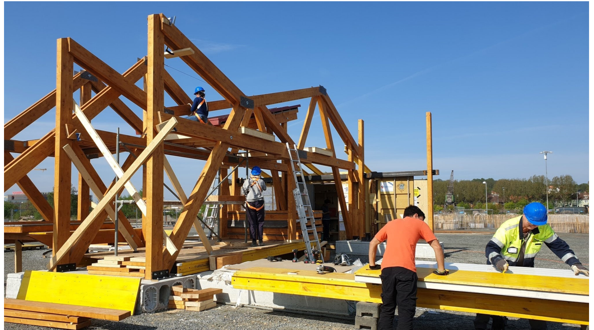
Vår 2019 byggdes ett modulärt uteklassrum med vattenlekplats i Jubileumsparken, Göteborg. Arbetet leds av Recetas Urbanas och genomfördes av allmänheten. MARELD gestaltade lekplatsen samt agerade som processtöd och lokal partner åt arkitekterna. Foto: Jubileumsparken.
