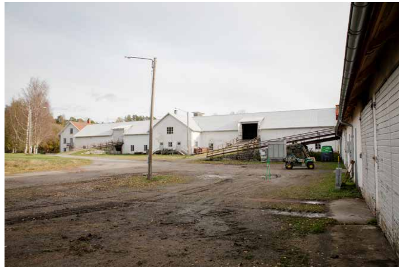
Stallbyggnaden, den leriga gårdsplanen mot ladugården, oktober 2023.
