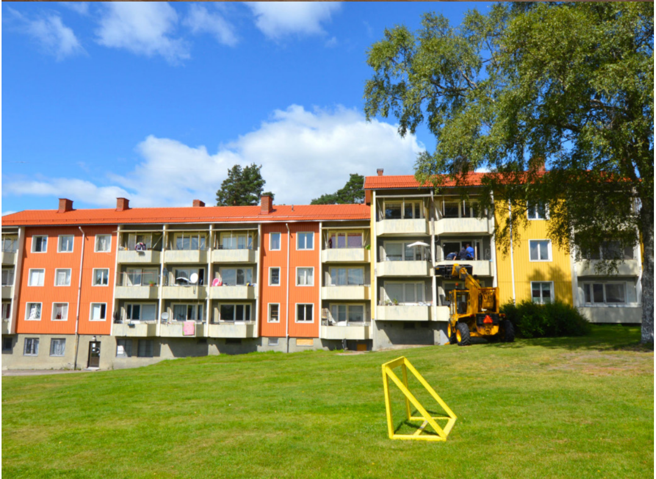
Bolagshagen Norberg, byggt i skiftet 1950- 60-tal för arbetare på gruvan i Kärrgruvan.
